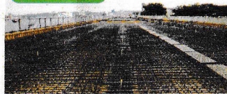
コンクリートを流し込む前の状態
