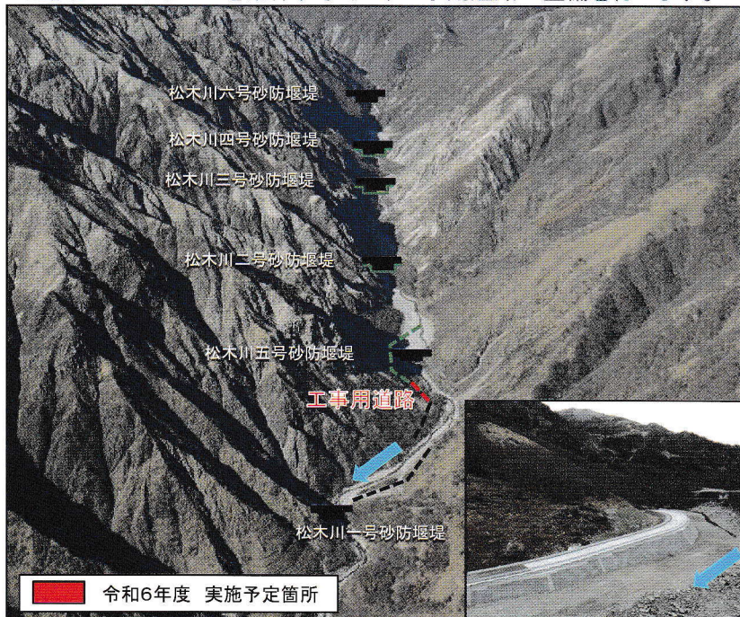
工事用道路の整備状況
