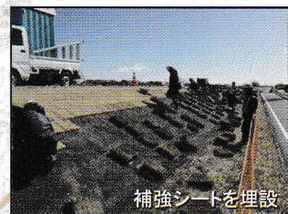
法面補修(イノシシ対策)
